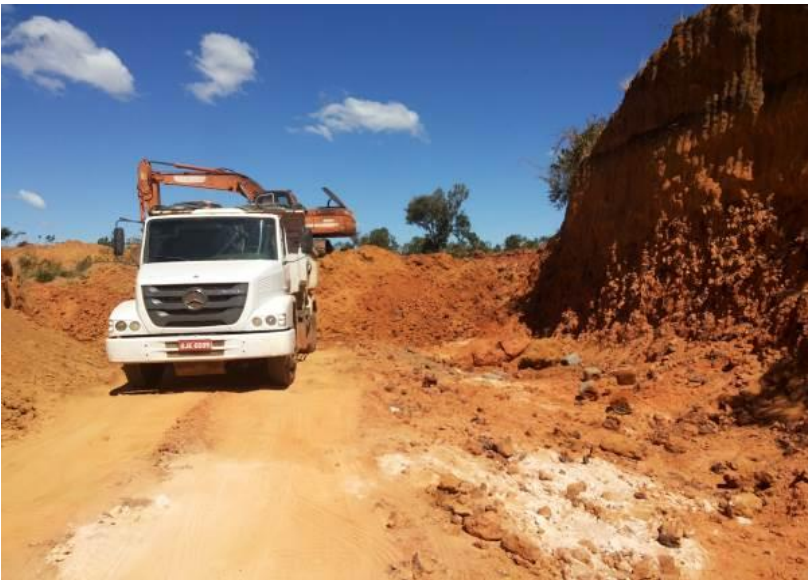
FIGURA 3.17 - Jazida 02 de cascalho, pertencente a particular, situada a 44,0 km do local do futuro aterro sanitário, indicada para pavimentação da via existente, da via de acesso e das vias internas do aterro
