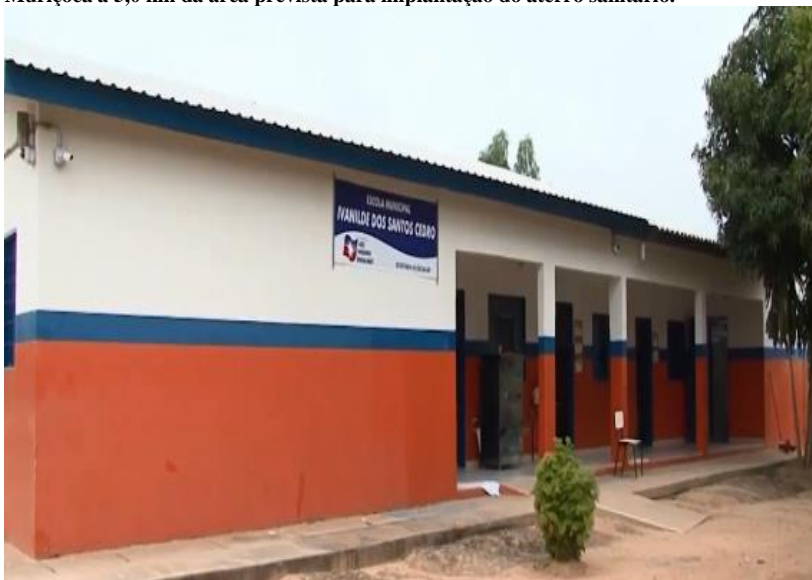
FIGURA 3.14 - Escola Estadual Ivanilde dos Santos Cedro, localizada na Comunidade da Muriçoca a 5,0 km da área prevista para implantação do aterro sanitário.
