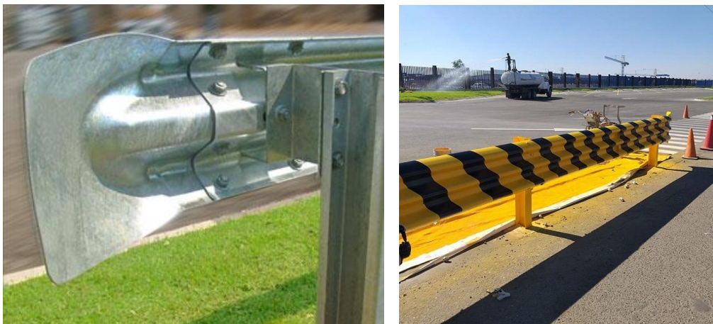
Imagens dos detalhes de instalação dos terminais aéreos e da pintura das defensas.
