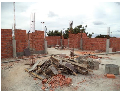
Figura 01 – Obra convencional, Hospital de Luís Eduardo Magalhães. Fonte: Prefeitura.
