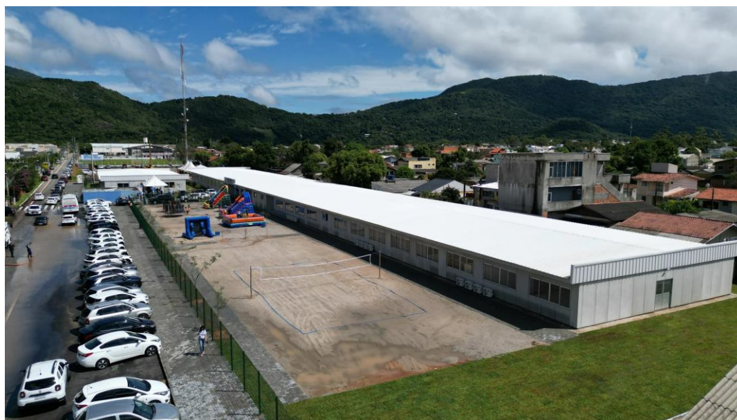
Imagem 02: A escola Darcy Ribeiro, em Florianópolis (SC), concluída em apenas 42 dias. Fonte: Internet
