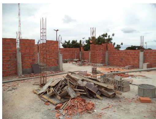
Figura 01 – Obra convencional, Hospital de Luís Eduardo Magalhães. Fonte: Prefeitura.
