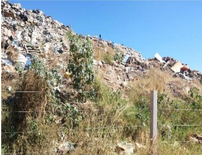
**FOTO 4.14** - Detalhe do aterro lançado sem nenhum controle, sem recobrimento, exposto a ação dos catadores e as intempéries, contaminando toda área com chorume.
