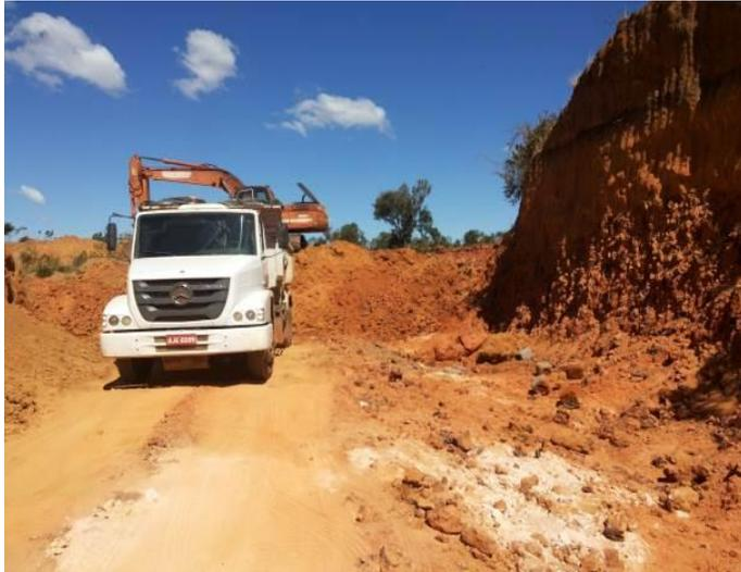
**FOTO 4.20** - Jazida 02 de particular de material argiloso, situada a 44,0 km do local do futuro aterro sanitário. Esse material tem sido utilizado com frequência em obras de terraplenagem na região, devendo ser utilizado nas camadas de impermeabilização das células do futuro aterro sanitário, devido as suas características argilosas.
