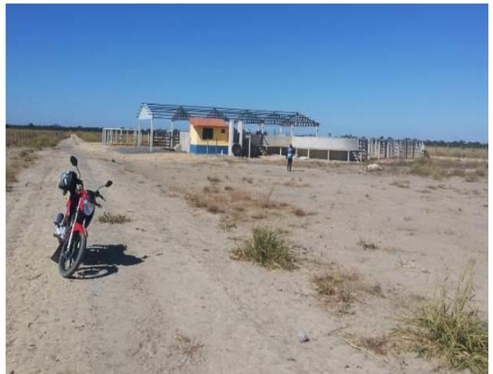
**FOTO 4.6** - Acesso existente do lado da área do futuro aterro que deverá ser pavimentado para atender ao tráfego de caminhões de lixo, principalmente nos períodos chuvosos.
