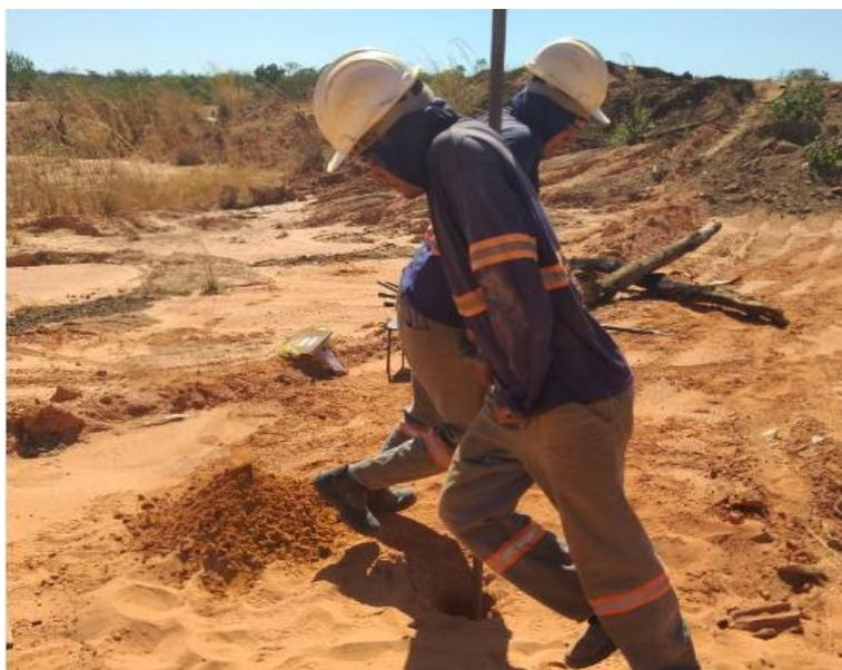
**FOTO 5.12** - Execução de sondagens a trado na área da jazida da Prefeitura para coleta de amostras e cubação do volume da jazida.
