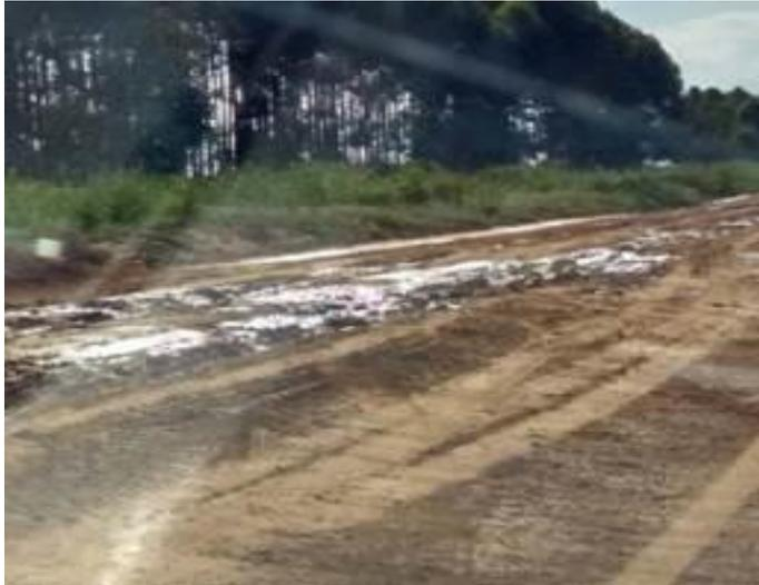
**FOTO 4.5** - Detalhe de um trecho do acesso existente a área do aterro, bastante afetado pelas chuvas, impedindo o tráfego de caminhões.
