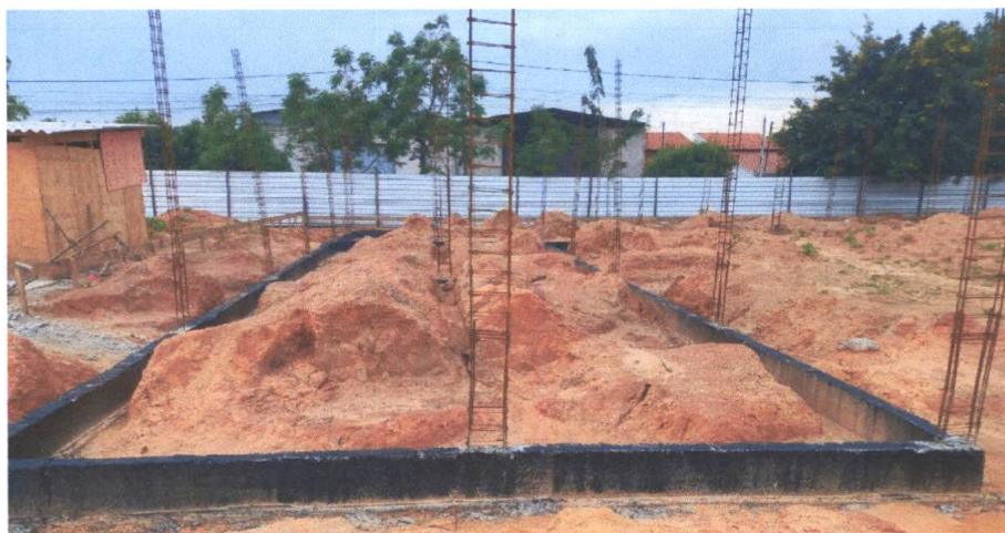
Foto 06 – Impermeabilização de Vigas Baldrame e Armação de Pilares
