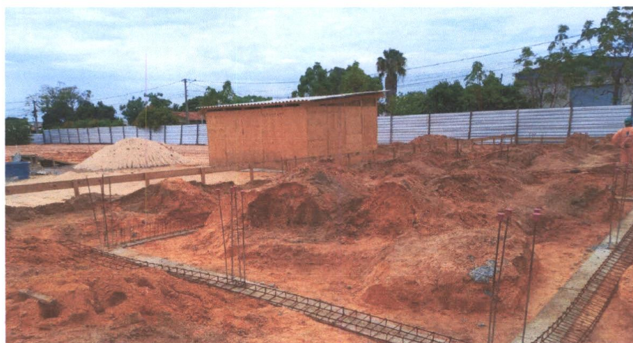
Foto 04 – Concreto Magro e Armação de Vigas Baldrame
