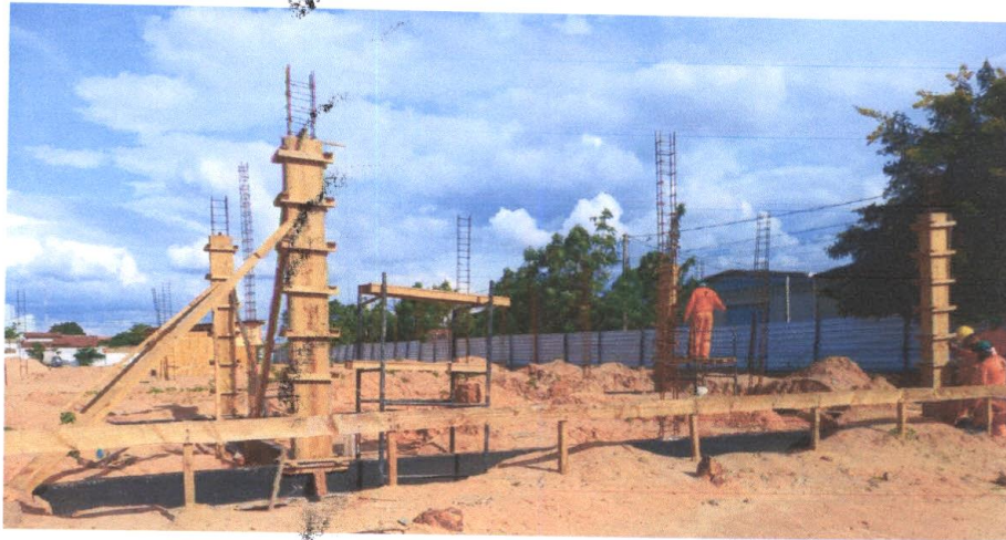
Foto 09 – Forma e Concretagem de Pilares
