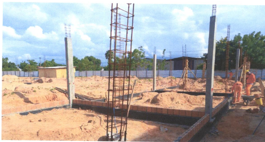
Foto 08 – Execução de 01º fiada de alvenaria
