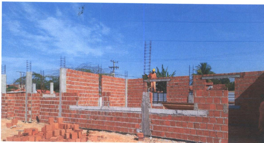
Foto 10 – Levante de Alvenaria
