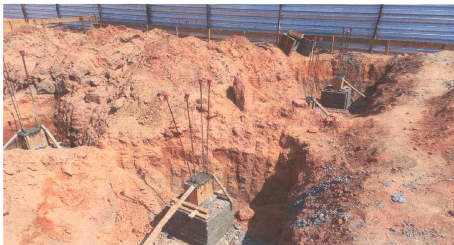
Foto 03 – Concreto em Arranques de Pilares
