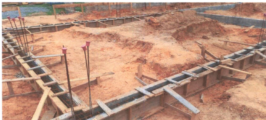
Foto 05 – Forma e Concretagem de Vigas Baldrame
